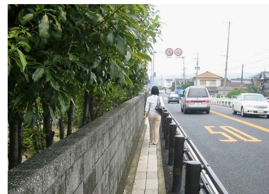
<防護柵の設置>
