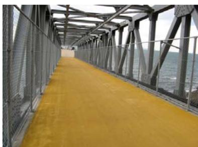
写真 工事中仮設栈橋に安全柵や舗装を追加しています
