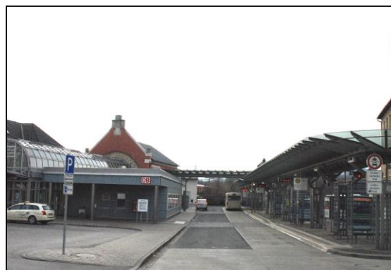
写真 4-3 ザールフェルト駅前広場
