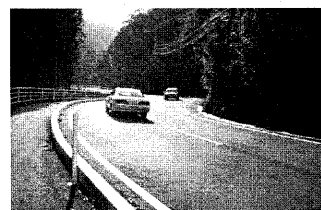
2車線+歩道整備
