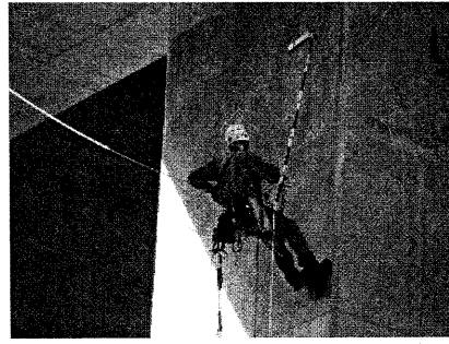
【橋脚のひびわれの発見】
