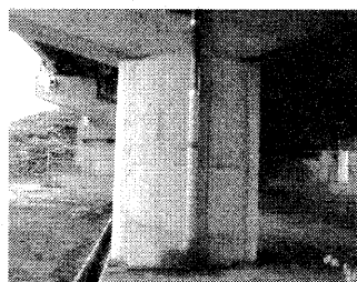
耐震対策が完了したため損傷がなかった例
