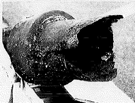
腐食した排水管
