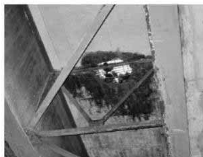
【疲労による橋梁の損傷】
