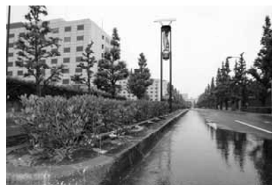
【保水性舗装と散水装置の設置例】
