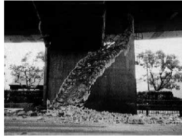
【兵庫県轄地震による橋脚の被災】
