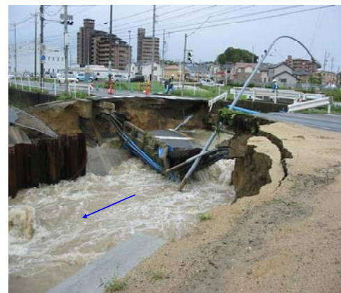
▲二級河川日長川及び国道 155 号東橋（愛知県知多市）【写真提供／愛知県】
