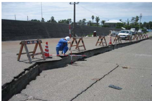
▲相良港（静岡県牧之原市相良）【写真提供／静岡県土木防災室】
