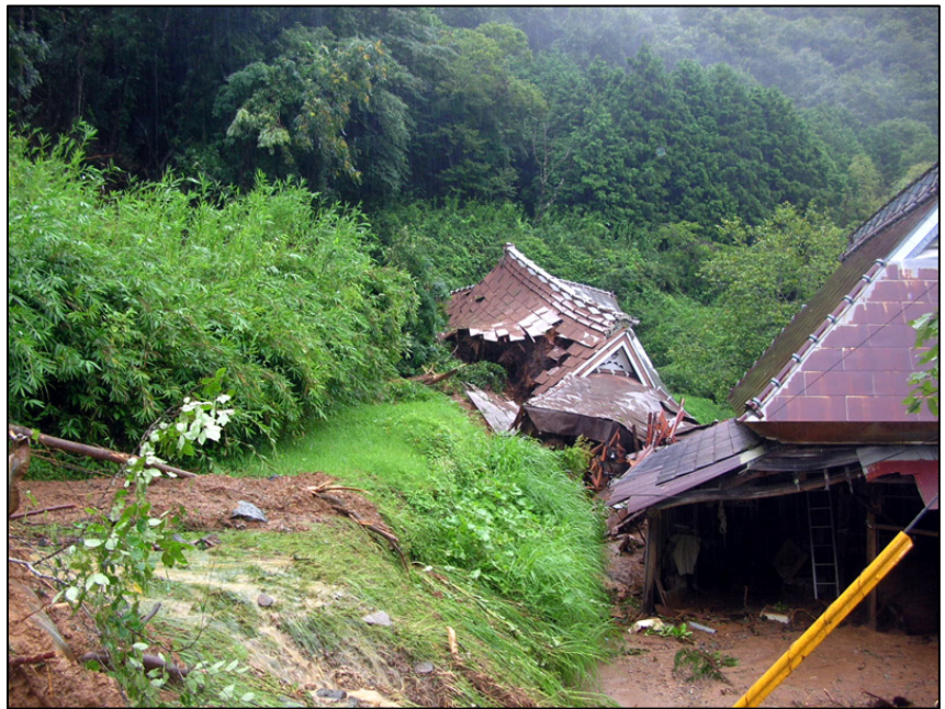
▲ 裏山が崩れ家屋が倒壊した [写真提供/岡山県美作市]
