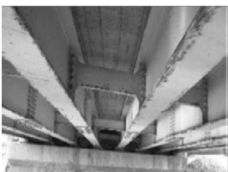
鋼材の腐食
