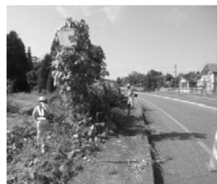
<除草作業の状況>
