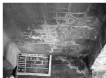
床版ひびわれ
