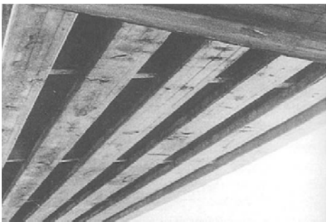
①1980年（15年経過） 主桁にひびわれ 錆汁が発生
