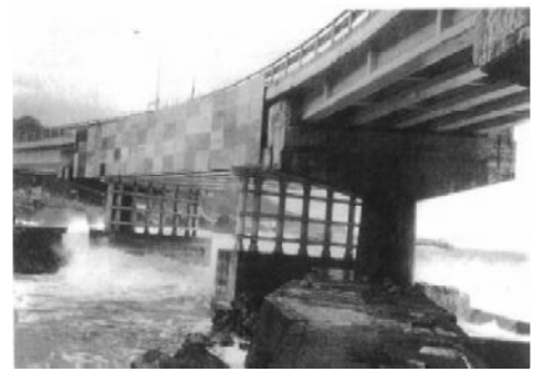
③1991年（26年経過） 耐荷力確保のために 新たに2基の支柱を設置
