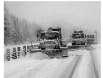
<除雪作業の状況>
