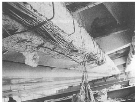
②1991年（26年経過） 主桁内部の鋼材が破断
