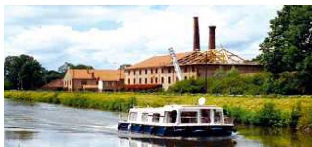
写真2：旧レンガ工場外観 （シリアルノーブル市資料）
