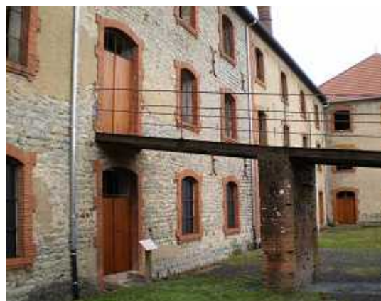
写真3 : 旧レンガ工場の未修復部分
