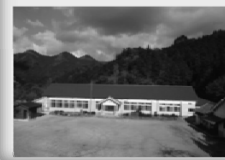
国登録有形文化財の 修理にあわせ駐車場 を整備 （三重県亀山市）
