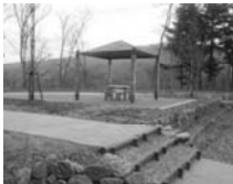
景観重要建造物の修理にあわせて、散策園路、休憩施設等を設置
