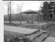
景観重要建造物の修理 にあわせ、散策园路及 び休憩施設を設置 （石川県金沢市）
