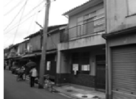
歴史的風致を損なっ ている建築物を、瓦 葺の印家の併並みに あわせるよう修景 （京都市）
