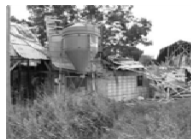
景観重要建造物周辺 の景観を阻害している 瓦葺の撤去を実施 （北海道黒松町）
