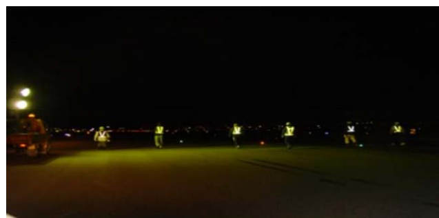
(巡回点検:滑走路等の不良箇所の有無を調べるため、夜間に点検を実施)
