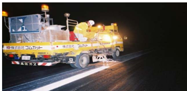
(飛行場標識維持:摩滅部分を復旧するために、標識の塗装を実施)
