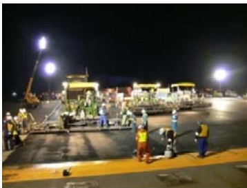
（滑走路舗装の更新・改良）
