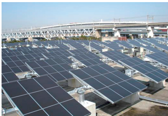
水処理施設上部の一軸追尾タイプ
