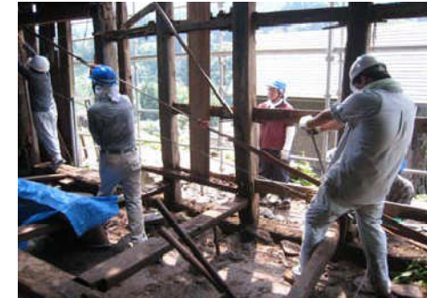
古屋修復作業の状況
