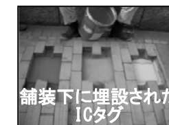
図2 空港内における視覚障がい者の移動案内 (ICタグ付き誘導用ブロックとICタグリーダー機能を有する白杖との組み合わせにより、位置特定を実施)
