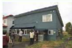
モデル住宅：空き家を改修
