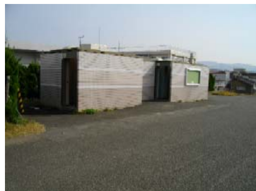
信濃川上流河川事務所近くのトイレ
