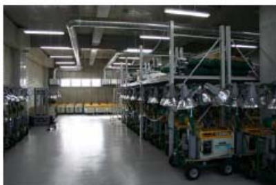
備蓄資機材（照明器）
