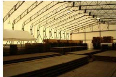
備蓄用テント内（敷鉄板）
