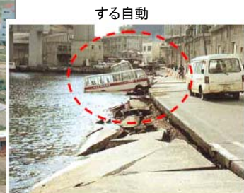
運輸省第三港湾建設局震災復興建設部 「よみがえる神戸港 阪神・淡路大震災からの復興の足跡」より
