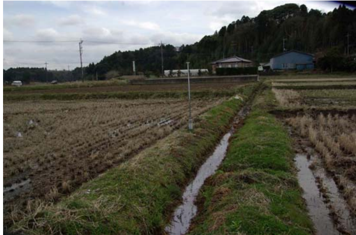
水田脇の土羽の小排水路
