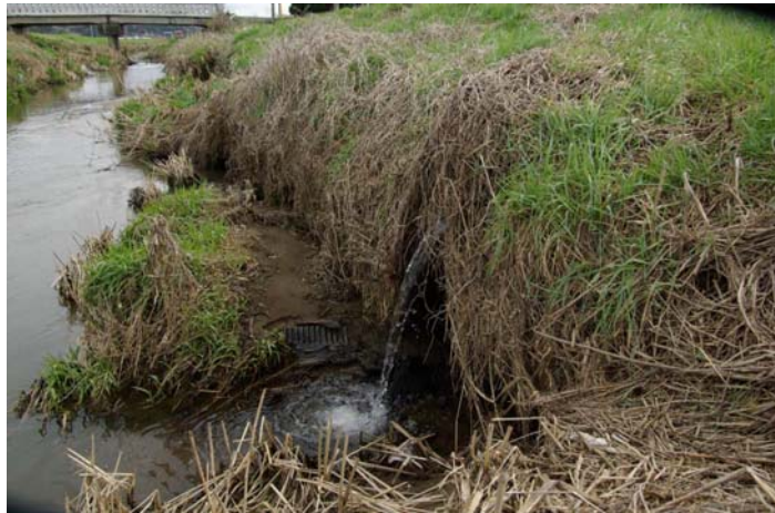
排水河川と排水路との接続状況
