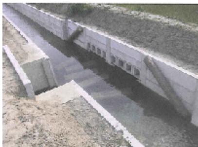
魚巢ブロック工
