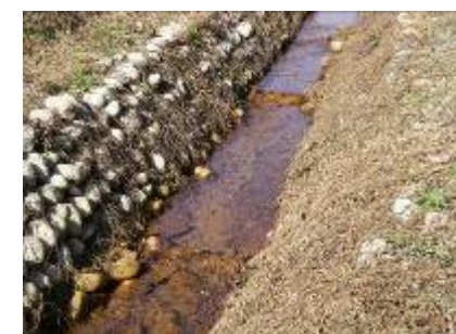
写真上：護岸位置に変化をつけたことで土の水際部が形成された 写真下：水路内に置石しよどみを確保
