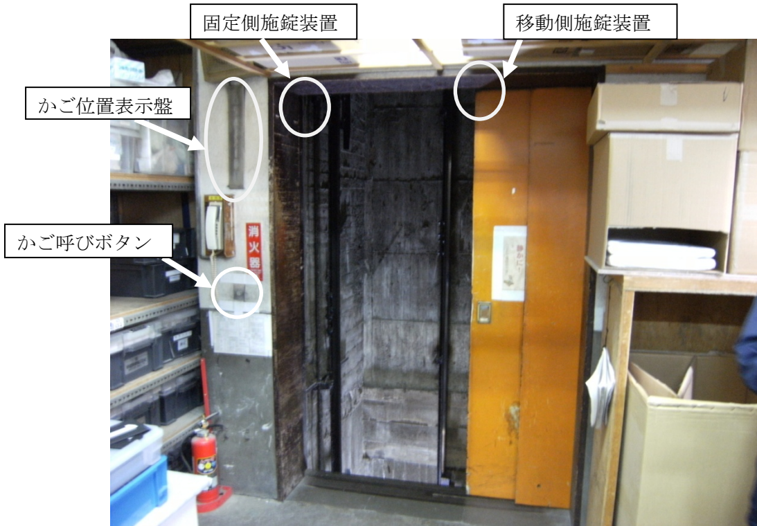
写真3 1階乗り場戸の状況
