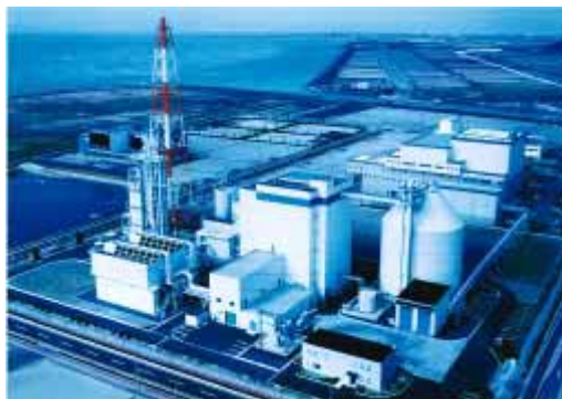
写真 3.4.20 大牟田リサイクル発電所
