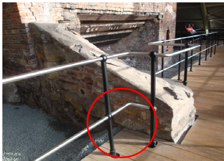
写真 2.4.5 0 見学用通路の設置と溶鉱炉跡の保全
