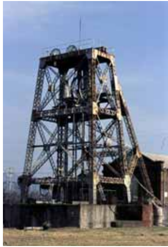
写真3.4.7 万田坑豎坑櫓
