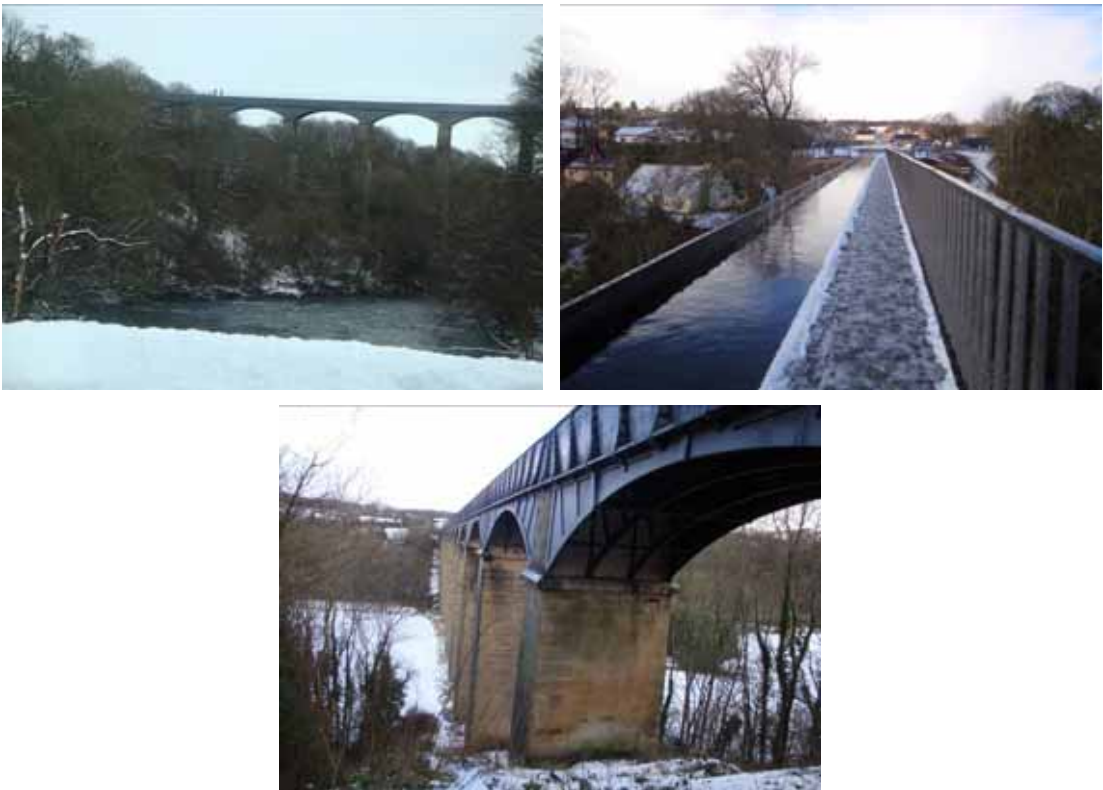
写真 2.4.5 2、5 3、5 4 ポントカサルテ水路橋景観
