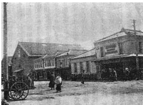
明治期の倉庫（左側）
