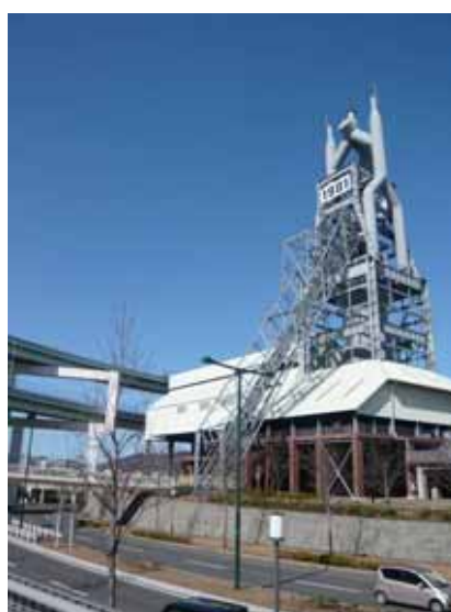
東田第一高炉
