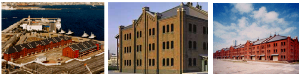
改修前の全体像
