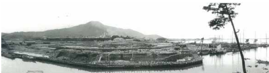
本事務所と建設中の初期工場群
