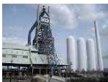
東田第一高炉跡
