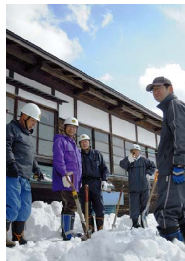
適宜休憩しながらの作業
