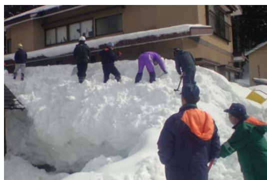
安全管理係が見守りながらの作業
