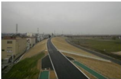
堤防の整備 (東京都 荒川)
