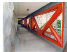
鉄骨ブレースによる壁の補強
