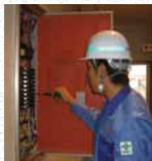
配電盤の点検の様子
