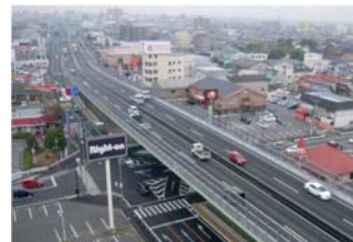
<大気質対策（交差点立体化 [国道2号]）>
