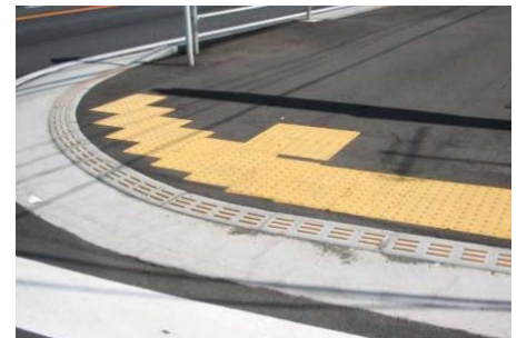
歩道の段差・傾斜・勾配の改善 視覚障がい者誘導用ブロックの設置
