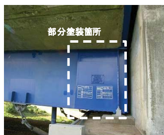
＜部分塗装による補修＞
