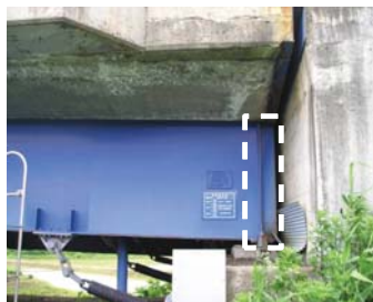
＜橋梁端部の腐食＞
