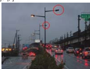
<高架橋照明の減灯>
