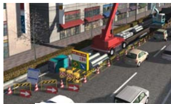
同時期に施工を行い、 工事日数を削減
