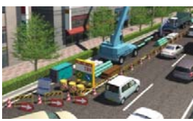
夏にガス工事
