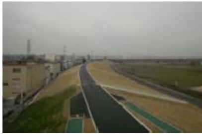
堤防の整備 (東京都 荒川)
