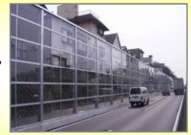
設置後: 63dB(夜間)
