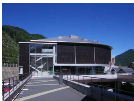
写真－3 森と水の源流館
