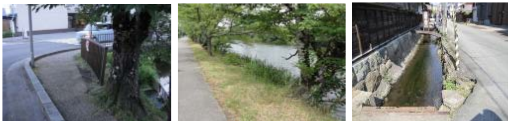
図 36 歩行空間ネットワークデータの取得時に注目した情報例 （左：マウンドアップによって狭小幅員のある歩道、中央：道路縁が不明瞭な場所、右：蓋の無い水路）
