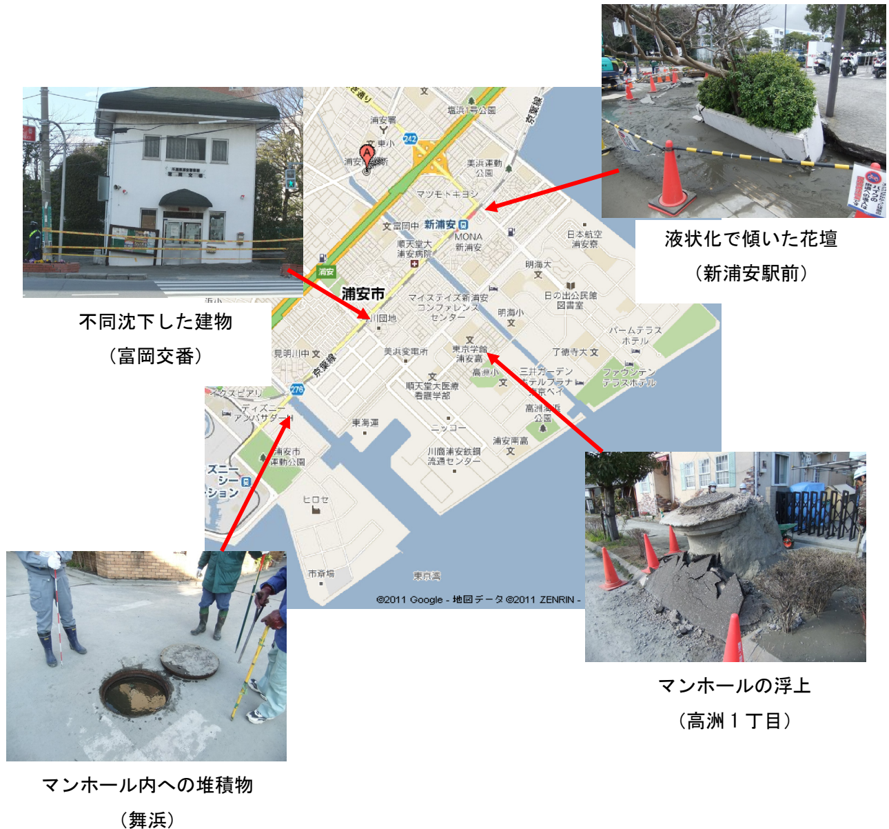
図 3-1 2 浦安市沿岸部の被害状況 (3月16日、27日、31日)
