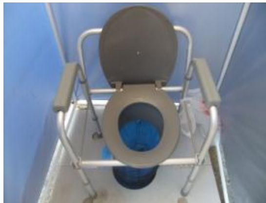
マンホールトイレ（洋式）
