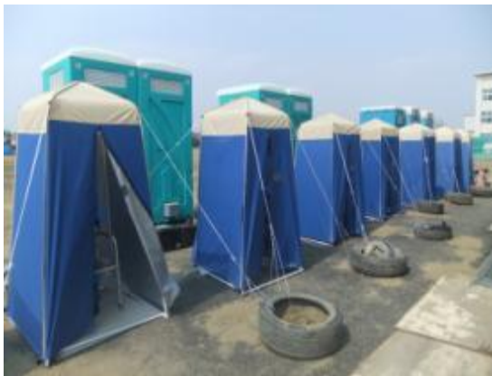
矢本第一小学校のマンホールトイレ
