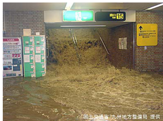
写真-9.2.1 平成 15 年 地下街浸水状況（福岡県） 2)
