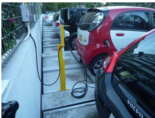
写真 3.2-8 パレットからケーブルがはみ出た例 (上下二段ピット式)
