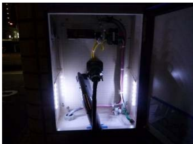
写真 3.2-10 充電コンセントの照明例
