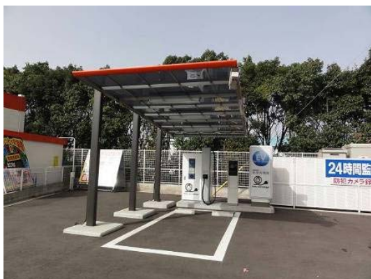
写真 3.2-3 充電施設の屋根の例
