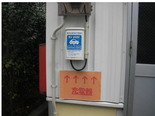
充電器設置状況
