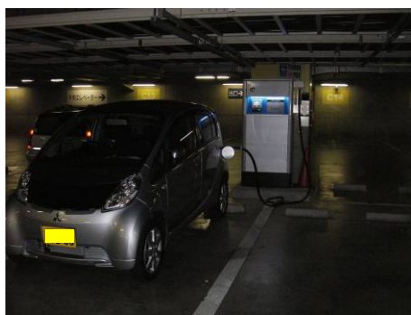
地下駐車場での充電状況
