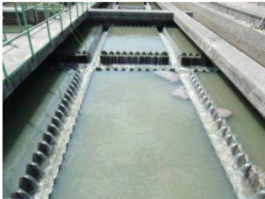
仙台市南蒲生浄化センター
