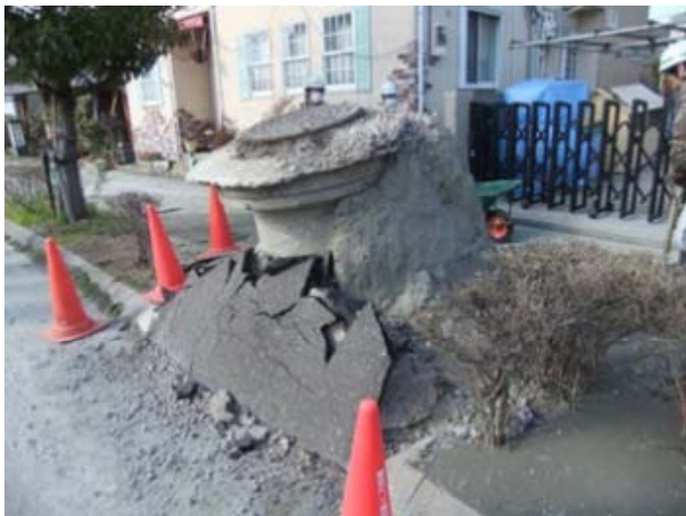
マンホールの浮上 (千葉県 浦安市)
