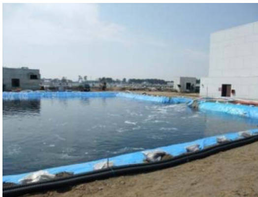
宮城県南浄化センター
