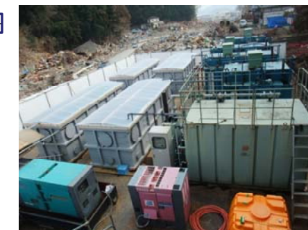
膜処理ユニットによる処理場と別位置 での応急対応(陸前高田市)
