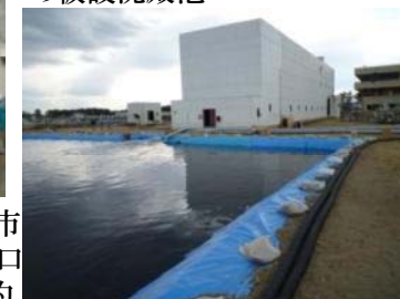
宮城県南浄化センターの仮設沈殿池
