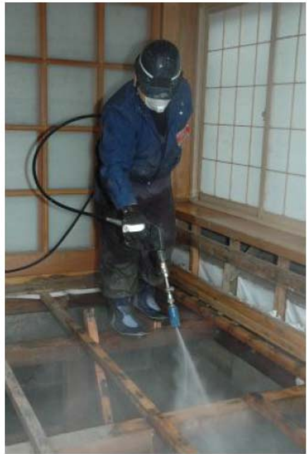
高圧洗浄機で床下に堆積した泥を洗い流す 東京都連・東建従の仲間
