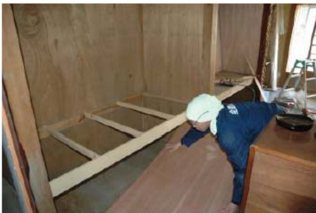
押入れに合板を張り付ける兵庫県連・神戸土建の仲間
