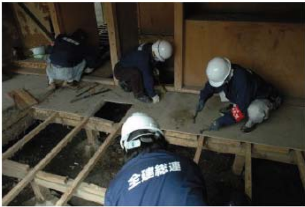
床板をはがす埼玉土建の仲間
