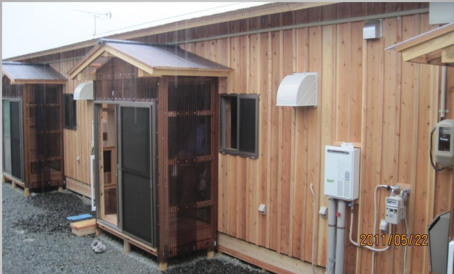
風除室の仕上がり状況。(ファーストステップ設置前)
