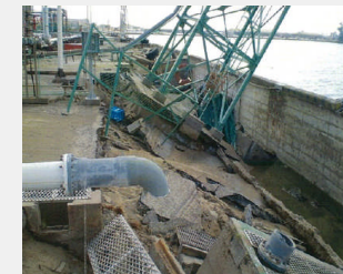
港湾設備の被害
