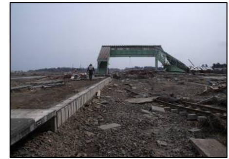
L: 常磐線 新地構内
