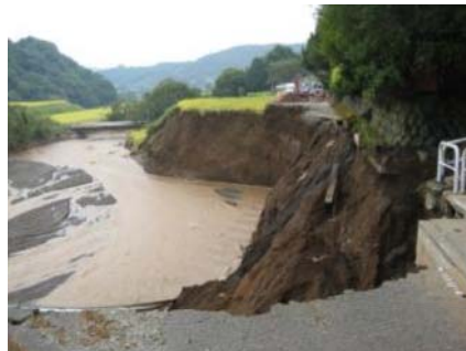
▲静岡県小山町（町道足柄三保線） 【写真提供／中部地方整備局】
