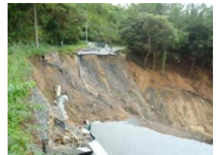
▲奄美市笠利町（県道601号道路陥没）【写真提供／奄美市】
