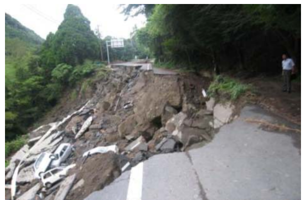
▲県道都城隼人線の被災状況 【写真提供／鹿児島県】
