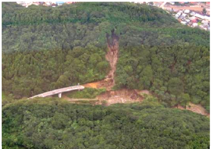
▲静岡県小山町（国道246号）【写真提供／中部地方整備局】
