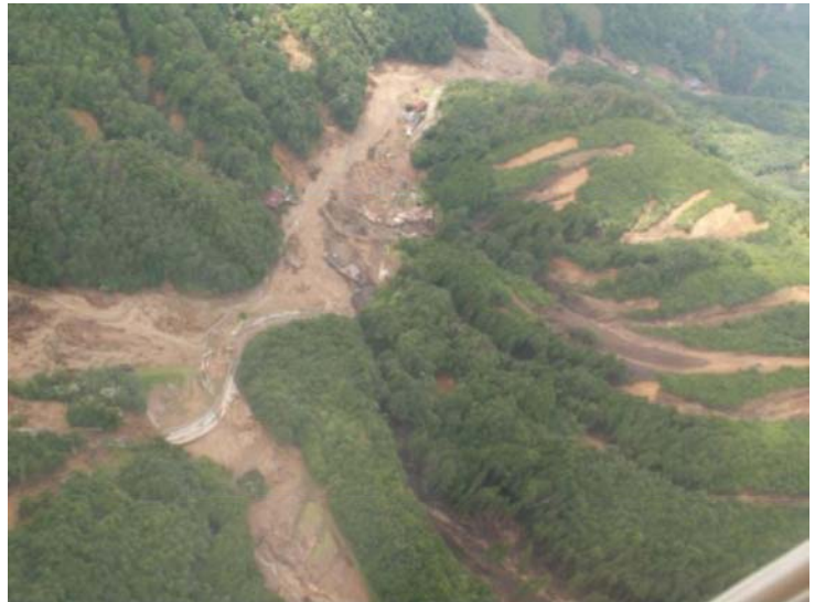
▲県道中迫川北線の被災状況【写真提供／中国地方整備局】
