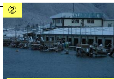
漁港浸水状況
