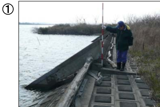
(被災状況: 低水護岸沈下、横帯拔上り)
