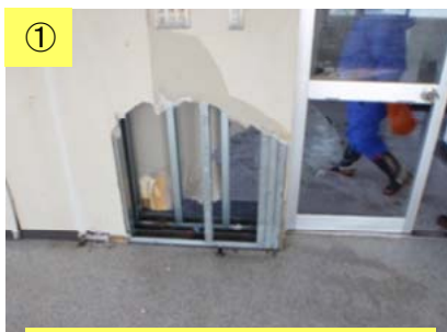
漁協事務所被害状況
