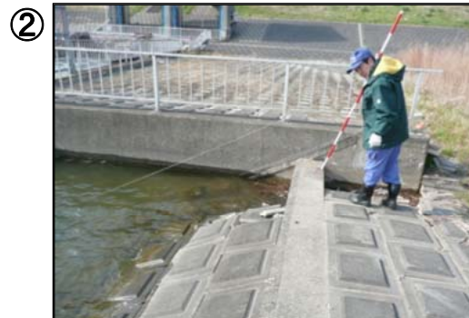
(被災状況: 取付水路沈下)
