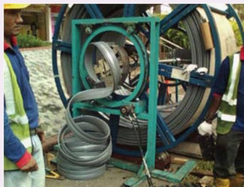
更生工法の一例
