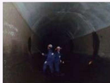
阿讃トンネル内部
