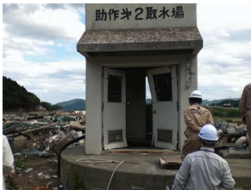
写真2-1-1：取水場の被害状況（南三陸町）
