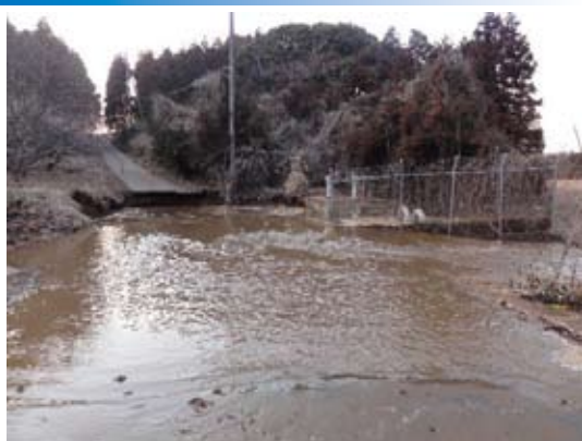
管路の排泥工の破損による地表面への出水 (排泥工：管路内の泥や水を管路外へ排出する設備)
