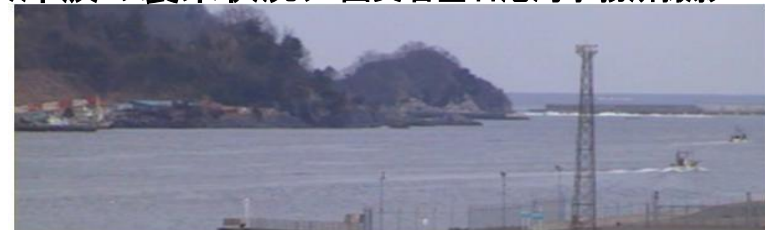
地震発生26分後：津波第1波がケーソン目地から流入
