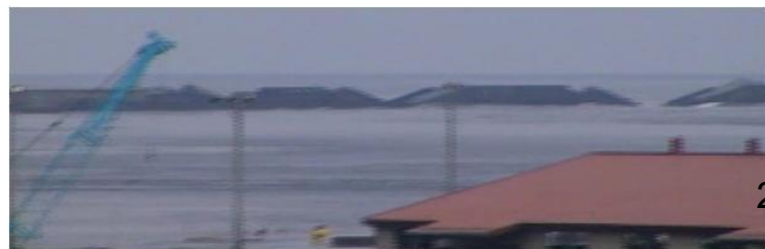
地震発生46分後：津波第1波が引き一部欠けた北堤
