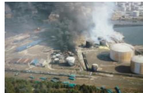
仙台製油所における火災発生状況
