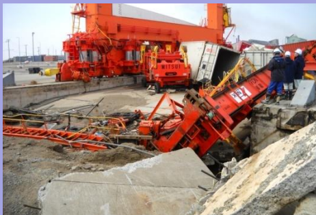
荷役機械の倒壊により荷役不能となった岸壁 (仙台塩釜港)
