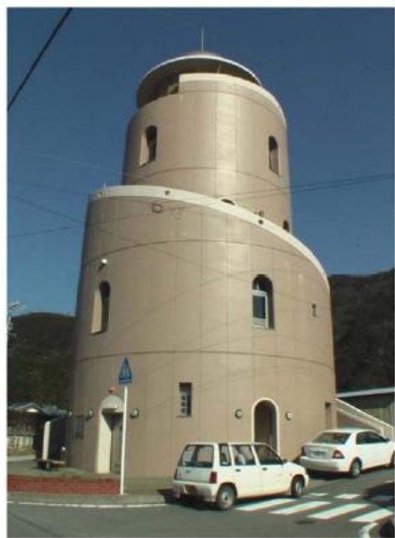
錦タワー（三重県大紀町）
