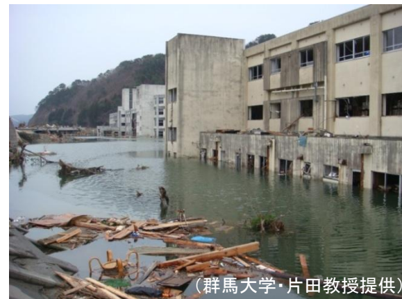
津波によって浸水した鶺住居小学校 31 (手前)と釜石東中学校(奥)
