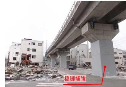
【耐震補強済み(鋼板巻立補強)地震動により損傷無し】
