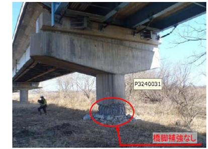
【耐震補強無し】橋脚が地震動により損傷
