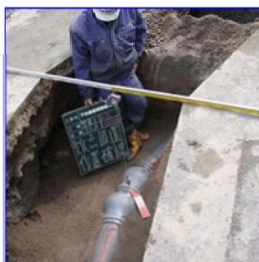
道路線形に合わせた施工(岡崎市)
