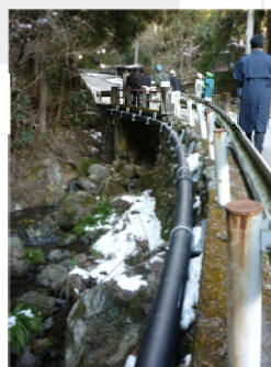
クイック配管(露出配管)(檜原村)
