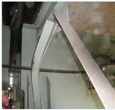
仙台東部道路 (仙台東～仙台港北)
